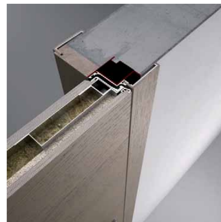
Soluzione 2 - Portone blindato a filo lato interno con mostrina, con imbotte in legno e mostrina lato esterno
